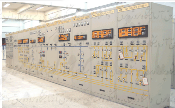
شکل (۱-۳): نمونه ای از تابلوهای قدرت و فرمان مونتاژ کارخانه
